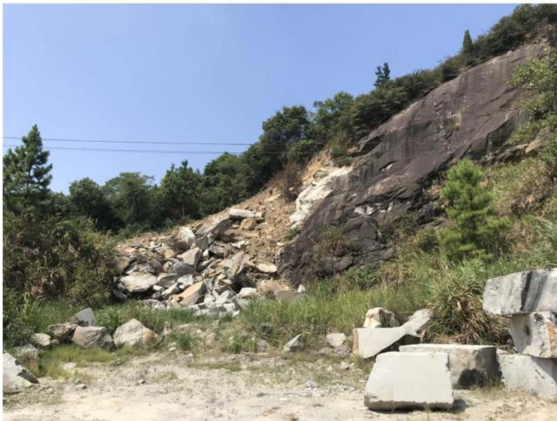
矿区外围老采坑 CK1 照片
