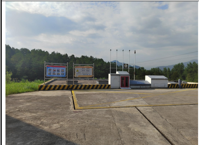
加油站油罐区
